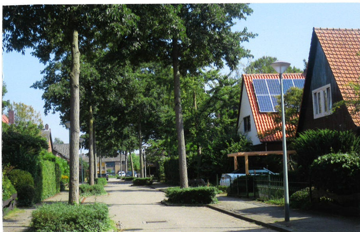
PATER-BLEYSLAAN 3, MET CARPORT, FOTO GENOMEN OP ZONDAG 5 SEPTEMBER 2021. ER WAS TOEN GEEN ACCORDERING EN GEEN VERGUNNING.
