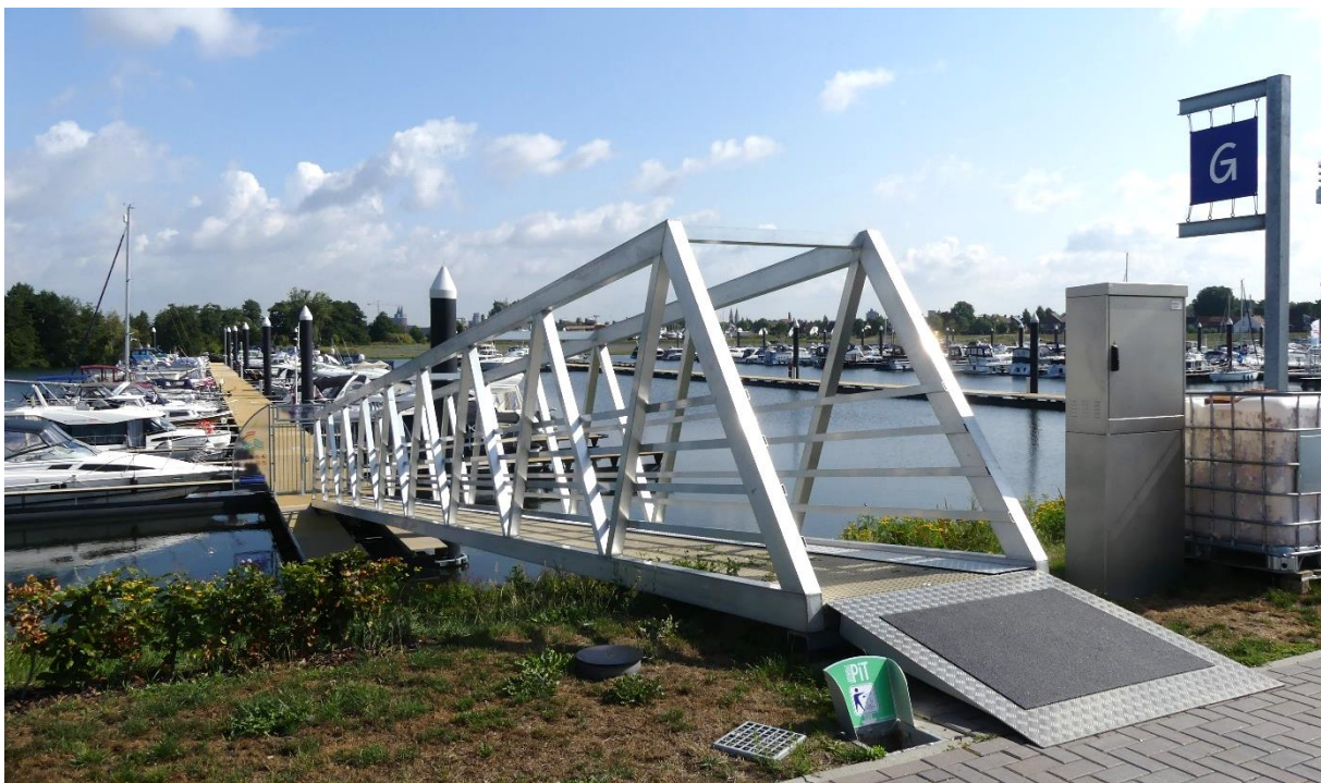
Roermond City Marina: verbinding wal – steiger incl. toegangspoort alleen voor ligplaatshouders.
